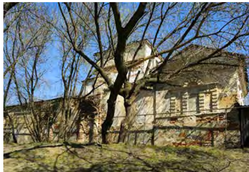
Здание Троицкого храма в г. Катайске Курганской области (современный вид)
