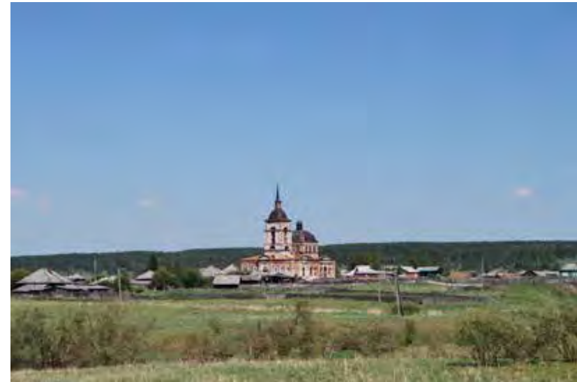
Вид на Троицкий храм и с. Харловское Ирбитского района Свердловской области (современный вид)
